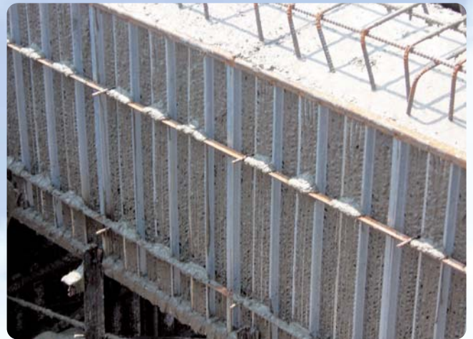
④コンクリート打設後
