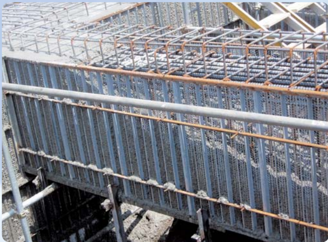
③コンクリート打設2
