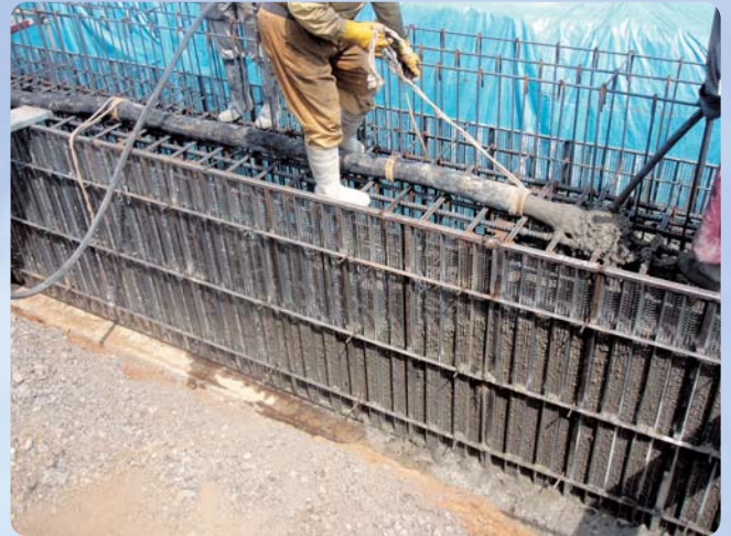
②コンクリート打設1
